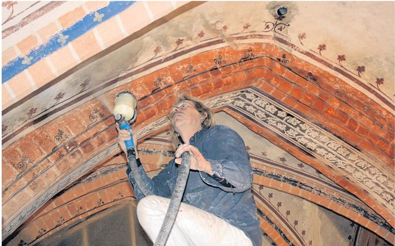
Bevor die Ornamente erneuert werden können, reinigt der Stralsunder Restaurator Peter Bindemann erst einmal die Wände.
